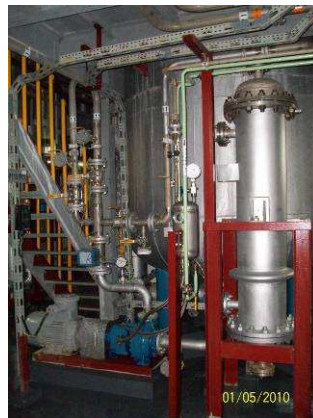
配有压缩油罐及组合式热交换系统的带双机械密封的泵
