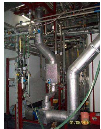
配有压缩油罐及组合式热交换系统的带双机械密封的泵
