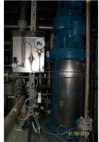
拉斯卡工程设计安装的气相润滑机械密封的监控装置
